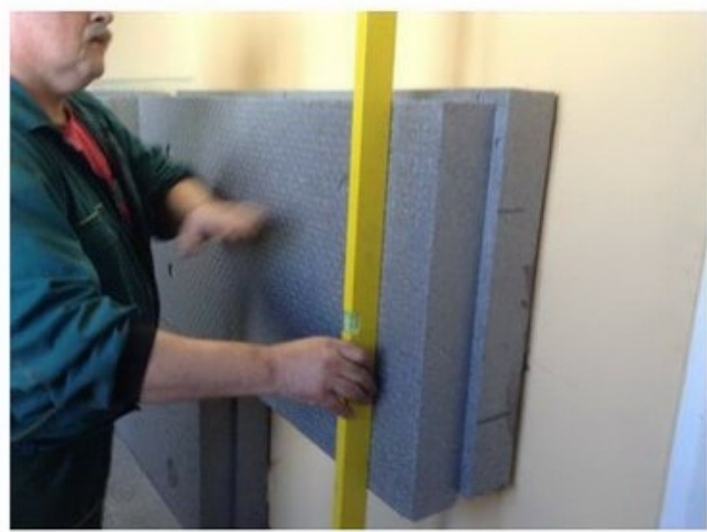
A felragasztott Premium TB Special tábla beállítása, ellenőrzése.
