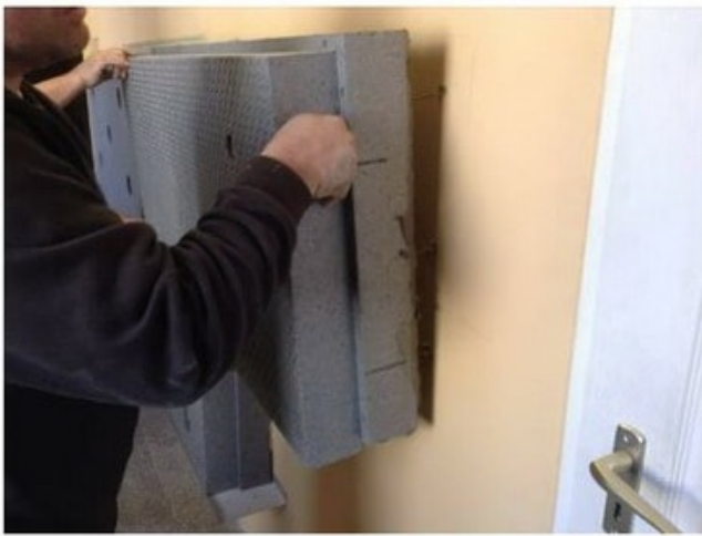
A Premium TB Special tábla falra ragasztása.
