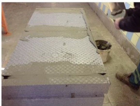
MAPEI Mapetherm Ragasztótapasz felvitele az EPS táblákra pont-perem módszer alkalmazásával.
