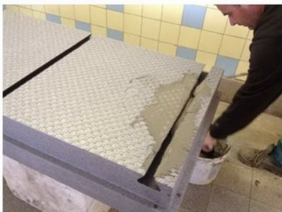
MAPEI Mapetherm Ragasztótapasz felvitele az EPS táblákra pont-perem módszer alkalmazásával.
