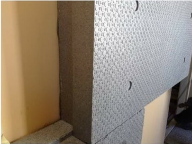
HŐHÍDMENTESEN felragasztott Premium TB Special tábla.
