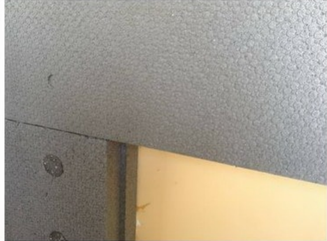
HŐHÍDMENTESEN felragasztott Premium TB Special tábla.
